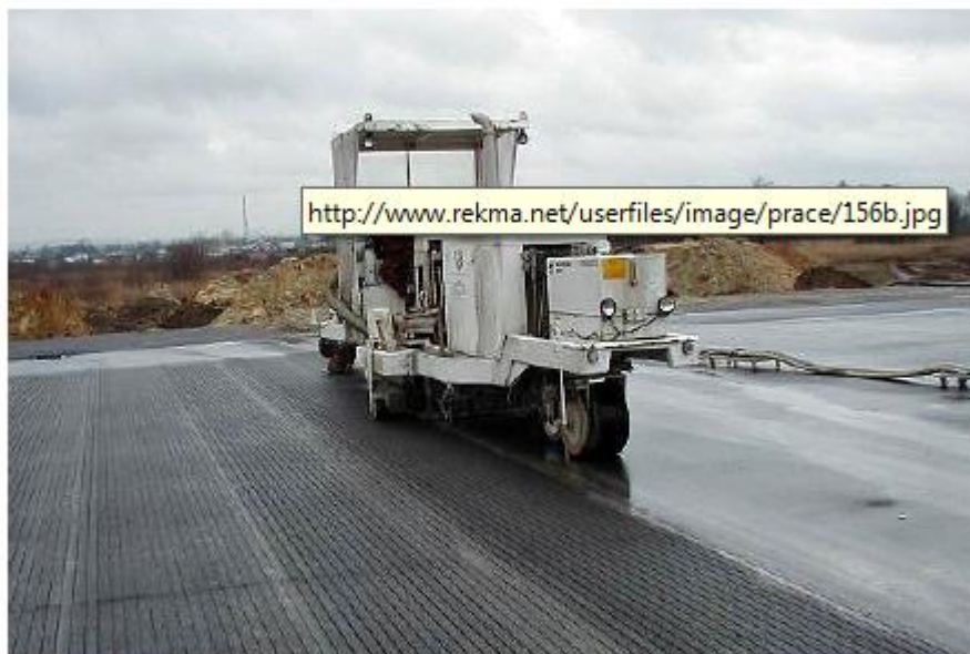
Рисунок А6-5. Нарезка канавок пилами
