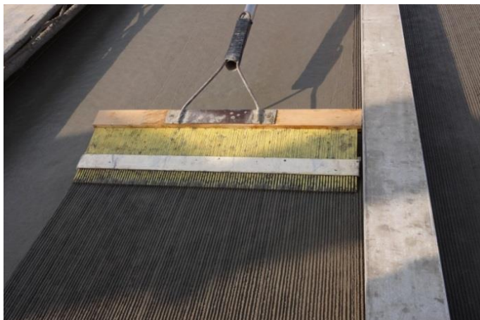
Рисунок А6-6. Новое бетонное покрытие с проволочной гребенкой
