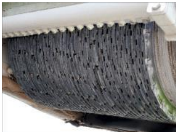
Рисунок А6-8. Алмазное шлифование цементобетона
