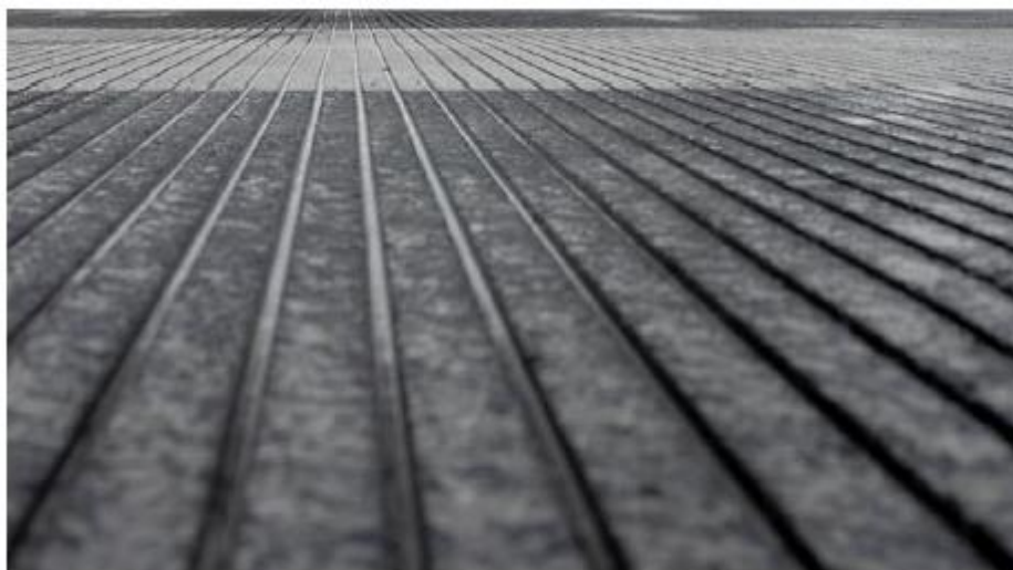
Рисунок А6-4. Бороздки на асфальтовом покрытии (шкала показывает деления 2,5 см)
