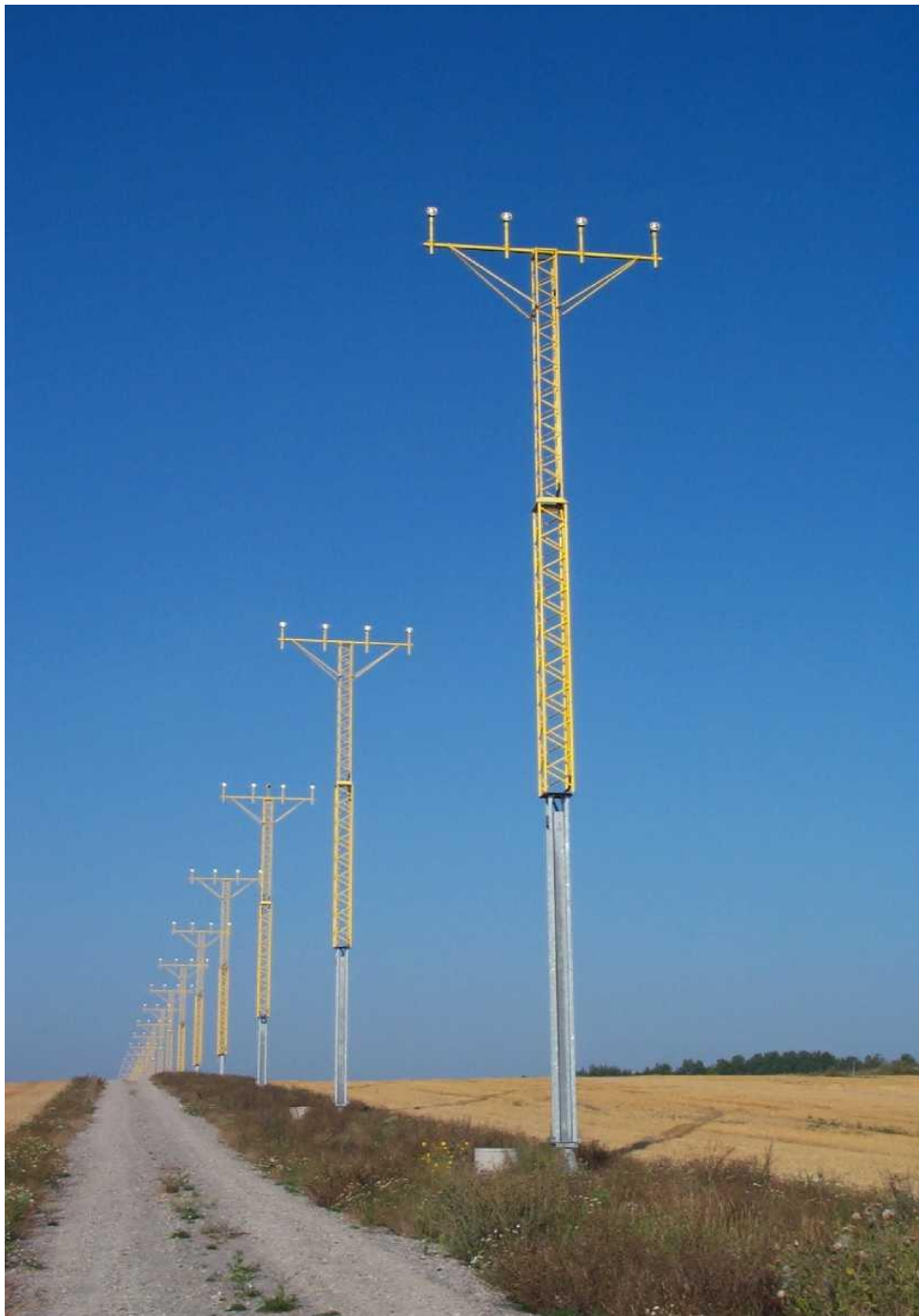
Рисунок 4-8. Стеклопластиковые опоры огней приближения на жестких поддерживающих конструкциях
