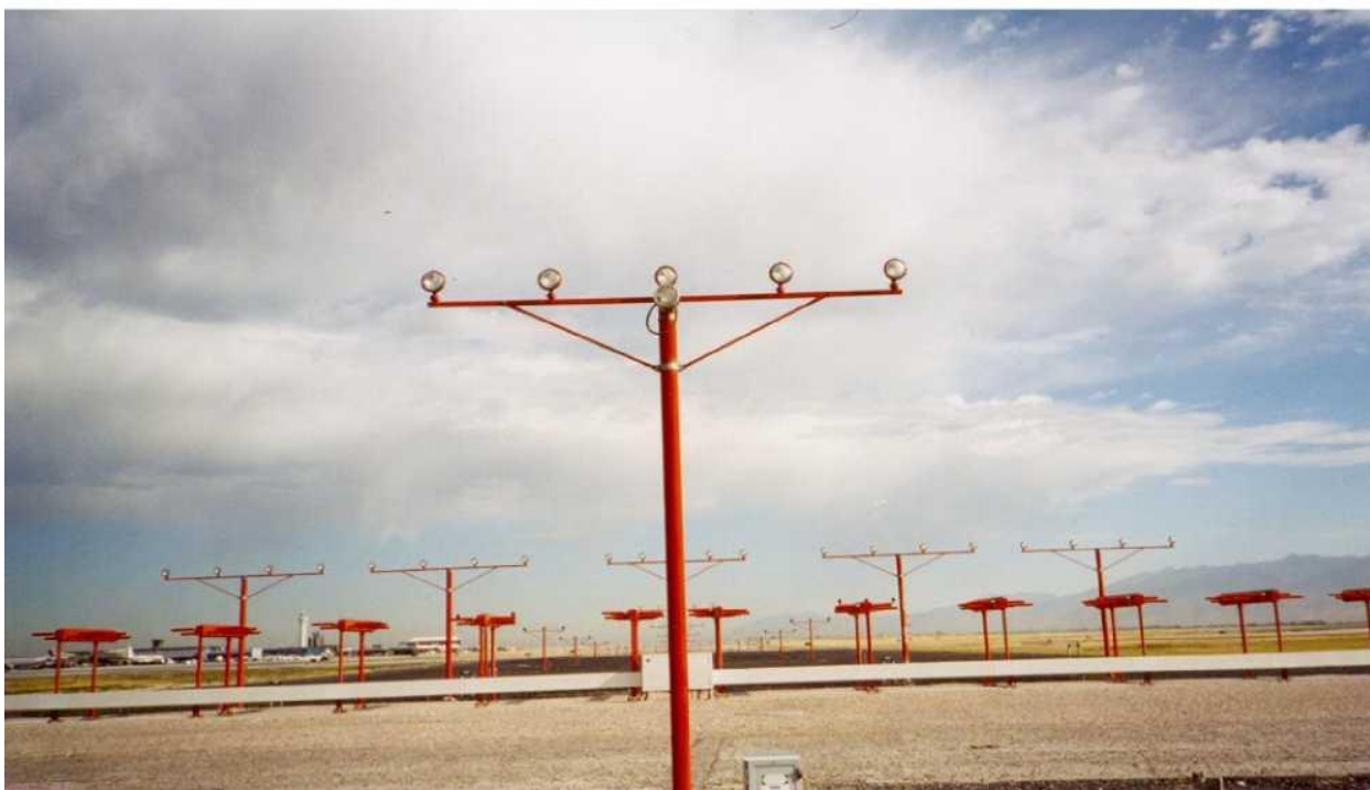
Рисунок 4-3. Опоры огней приближения – стеклопластиковые трубчатые столбы
