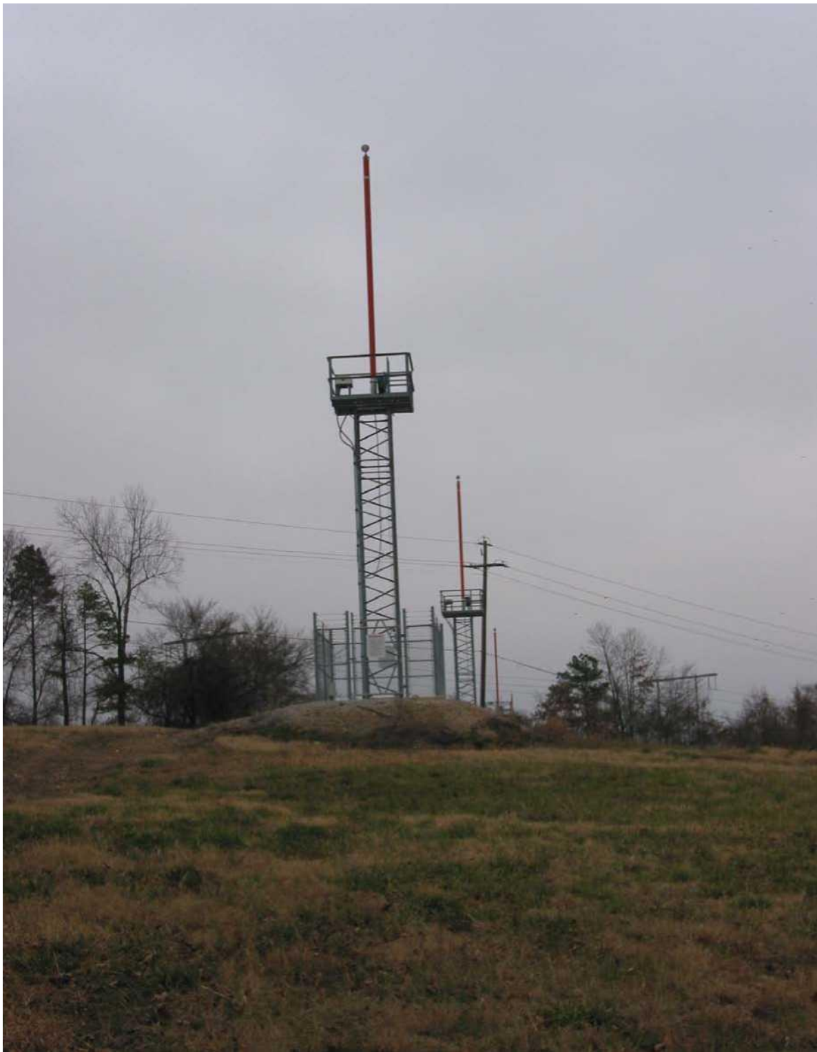
Рисунок 4-7. Стеклопластиковый трубчатый столб на жесткой опоре
