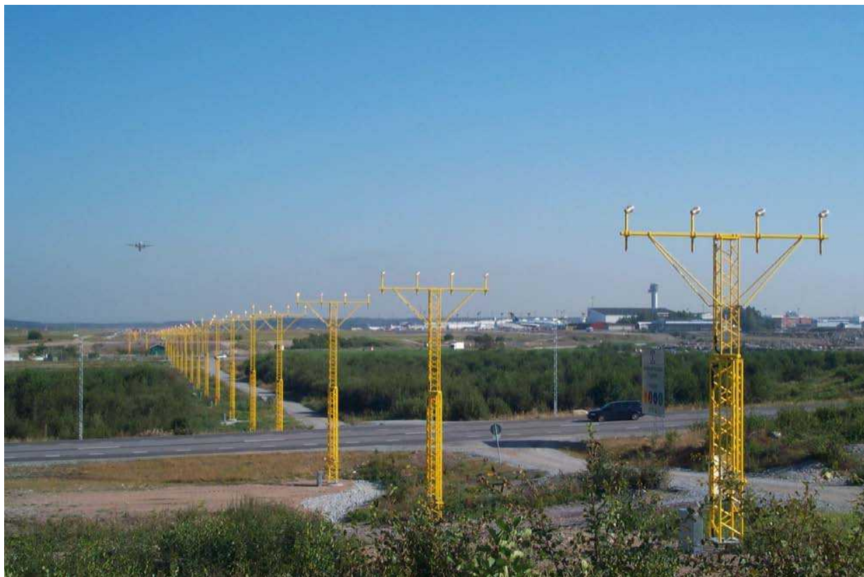
Рисунок 4-2. Опоры огней приближения – стеклопластиковые решетчатые конструкции
