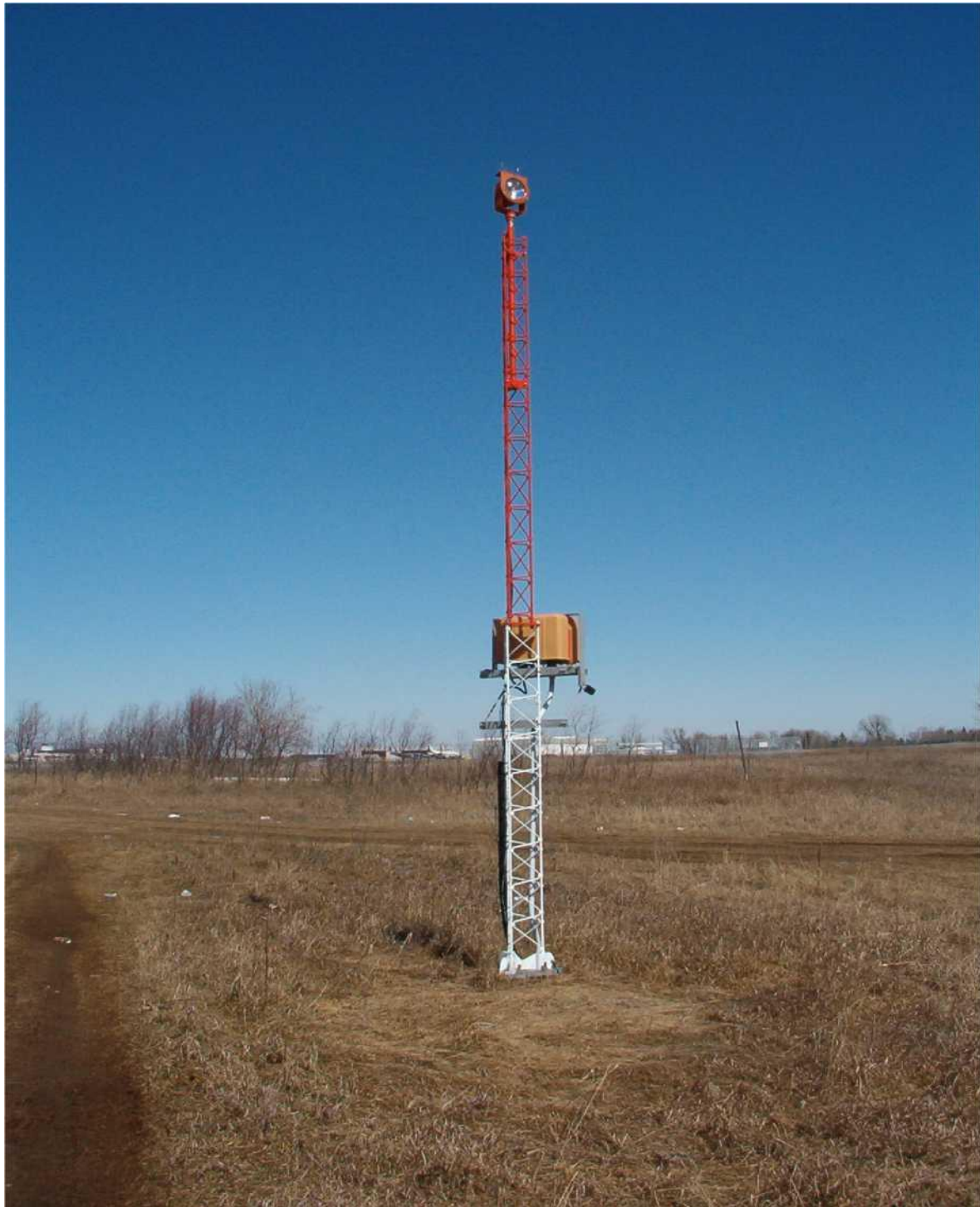
Рисунок 4-5. Опора огня приближения крупным планом – алюминиевая решетчатая конструкция
