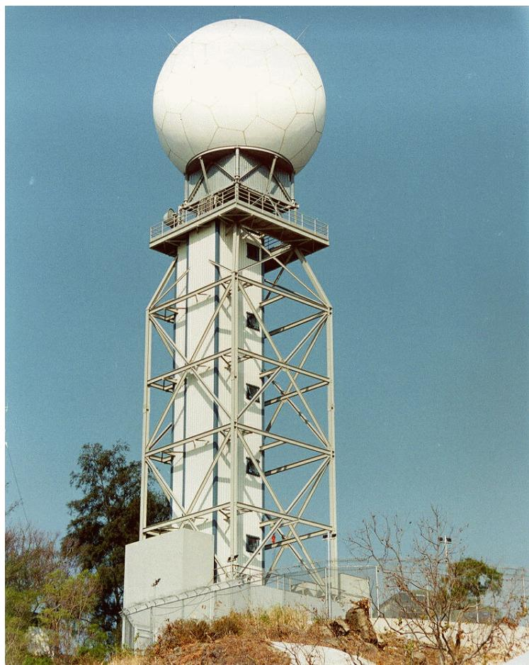
Рис. А4-7. Аэродромный доплеровский метеорадиолокатор в Гонконге
